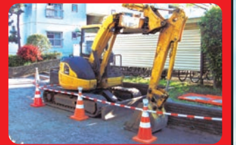
工事現場の注意喚起
